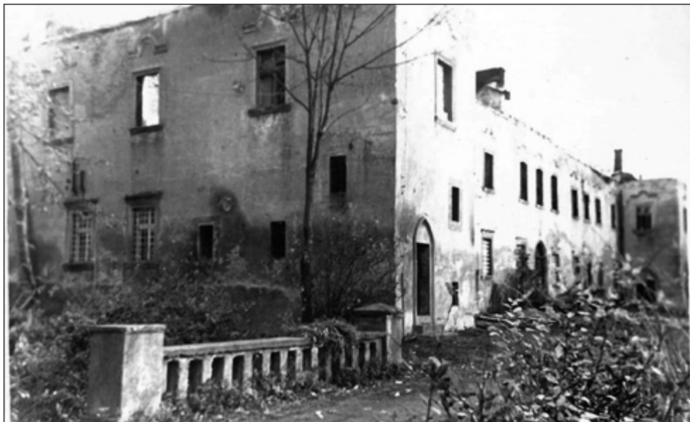
Pałac w Głębowicach po 24 latach gospodarki komunistycznej...
