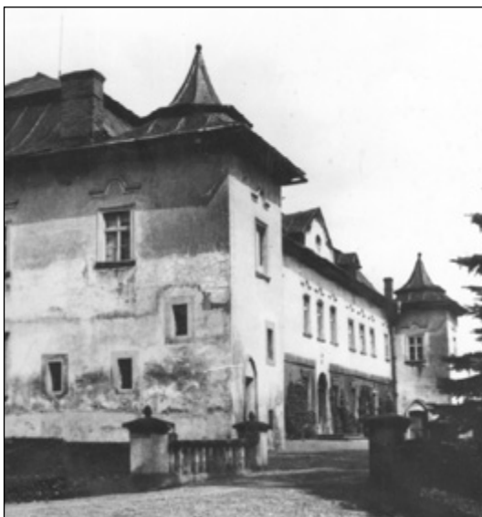
Głębowice, strona zachodnia i wjazd na dziedziniec od strony południowej
