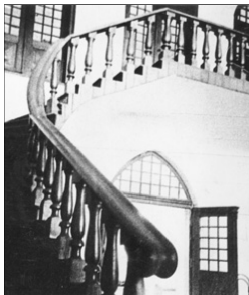
Hall i schody na I piętro
