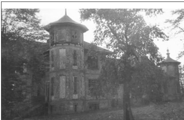
Kopytówka, strona północna, zajazd, mała wieża z prawej strony, w której mieściła się kaplica
