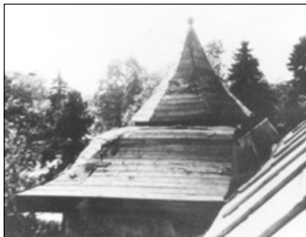
Przy pokrywaniu dachu blachą nie pokryte zostały wieże, wskutek czego woda zalewa obydwie wieże. Brak rynien powoduje zacieki na murach. Zdjęto polepę i nie założono nowej, oddając na pastwę pożaru całe I piętro
